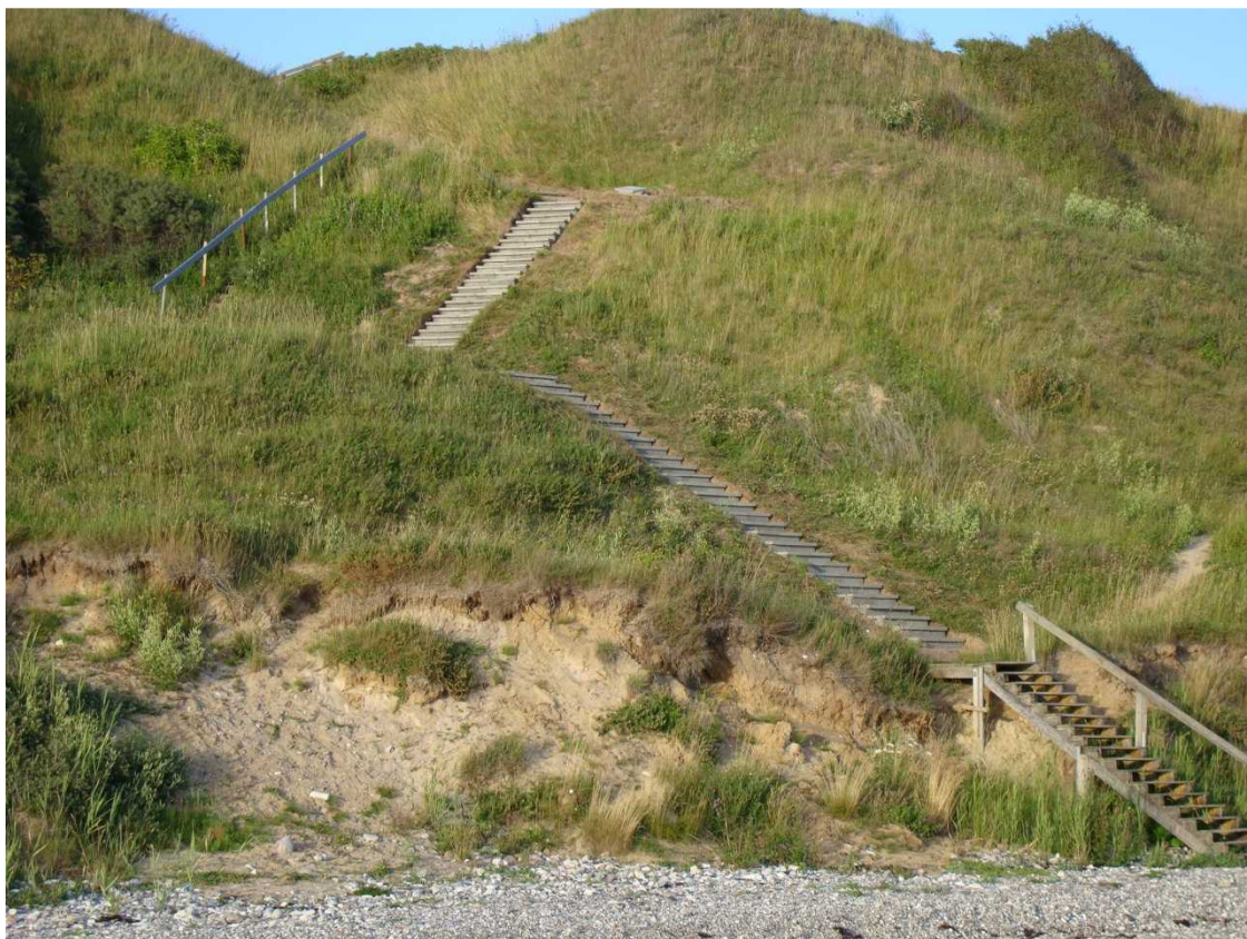
Nyetableret trappeanlæg indbygget i skrænten.
